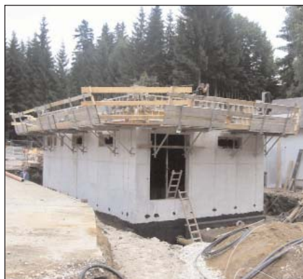
Betonarbeiten an der neuen Pumpstation Sternstein (Durchsatz: 84 l/sec.) in Bad Leonfelden/Oberösterreich
