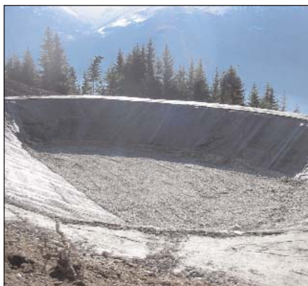
Beschneigungs-Anlage Hüttegg: Retentionsbecken für Abflussfracht (Fassungsvermögen: 2.500 m 3 )
