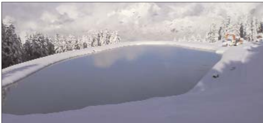
Speicherteich der neuen Beschneigungs-Anlage Hüttegg im Skigebiet Hausstatt am Weerberg/Tirol (Gilfertlift GmbH & Co. KG) Fotos: AEP
