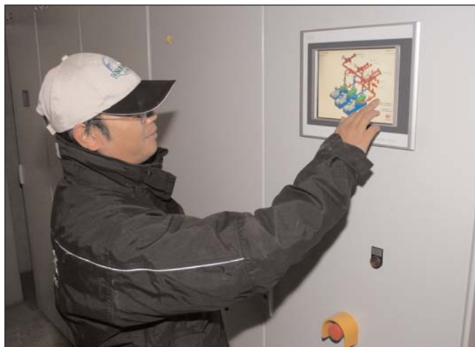
Mit der neuen Pumpstation bei der Karlesjoch-Bahn wird das Schnei-Wasser auf den höchsten Punkt des Skigebietes auf 3.100 m gebracht.
