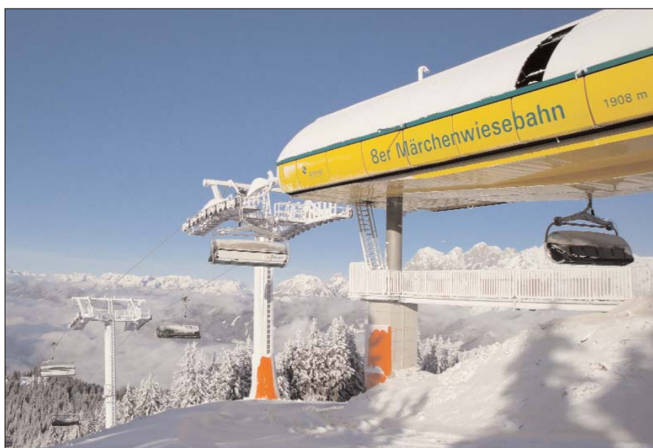
Die neue 8er-Märchenwiesebahn auf der Planai in Schladming ist mit einem 1.560 Meter langen TEUFELBERGER-Seil ausgestattet Foto: Planai-Hochwurzen-Bahnen
