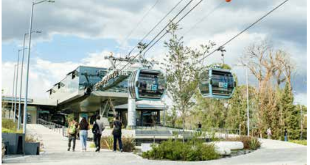
DOPPELMAYR hat in Mexiko-Stadt die Cablebús-Linien 1 und 3 (im Bild) realisiert, aktuell wird in Uruapan eine weitere Seilbahn gebaut. Damit entsteht in Mexiko die umfangreichste urbane Seilbahninfrastruktur – mit künftig mehr als 50 Kilometern Gesamtlänge, die über 350.000 Fahrgästen täglich eine verbesserte Mobilität bietet. © DOPPELMAYR
