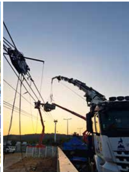
Mit dem Litzenspanner Strand Jack verschob POMA die Tragseile von Téléo in einer Rekordzeit von 4,5 Tagen. © POMA
