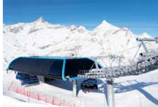
Solarmodule kommen nicht nur in urbanen, sondern auch in alpinen Seilbahnanlagen zum Einsatz. Auf den Fotos: die Sesselbahn Gauxjoch im Skigebiet KitzSki, Österreich, (links) und die Sesselbahn Gifhittli in Zermatt, Schweiz (rechts). © LEITNER
