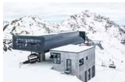
Bei der Sesselbahn Waidofen in Österreich sind Solarpaneele direkt in die Stationsgebäude integriert – eine Lösung, die ästhetisch und funktional überzeugt.
