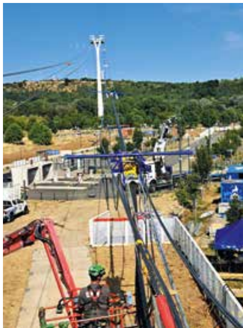
Mit dem Litzenspanner Strand Jack verschob POMA die Tragseile von Téléo in einer Rekordzeit von 4,5 Tagen. © POMA
