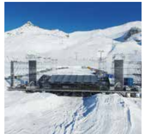
Bühnenbau in Ischgl. © Silvrettaseilbahn AG
