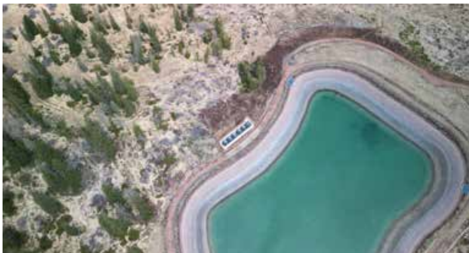
Kaltes Wasser bleibt der Schlüssel – und mit optimierten Kühlturm-konzepten wird dieser Schlüssel künftig noch effizienter genutzt.
