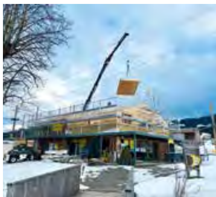
Die Arbeiten am Talrestaurant Kronberg begannen im Januar 2026. © Kronberg AG
