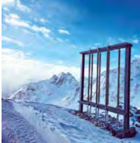
So sieht ein Teil des Systems nach dem Einbau aus.
