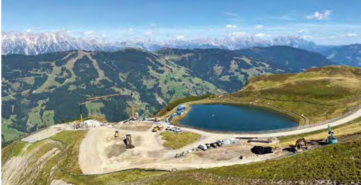
Der neue Speicherteich Schattberg sorgt in Saalbach-Hinterglemm für ein deutlich größeres Wasservolumen. © ILF
