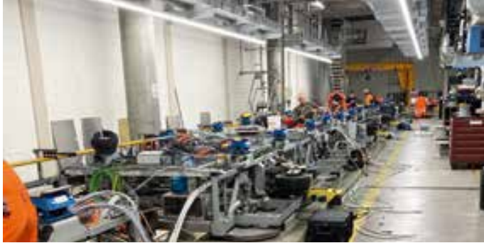
Direkt vor Ort werden die Wagen im Wartungsbahnhof umgebaut. Die Elektrotechnik wird komplett erneuert, die Hydraulik revidiert.
