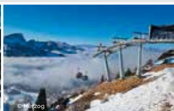
10EUB Gartnerkofelbahn Nassfeld, Baujahr 2025
