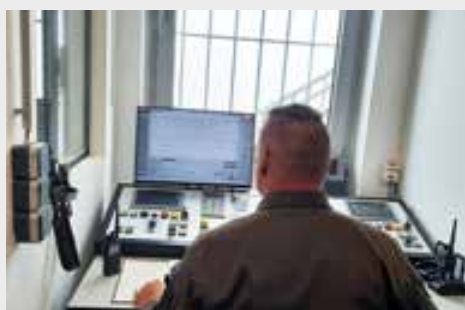
Die Seilbahn wird vom Bedienstand aus gesteuert (links). Zum Eis-Abfahren können jedoch auch Mitarbeiter der Planai-Hochwurzen-Bahnen über eine Bedienstelle im Außenbereich die Bahn rudimentär steuern (Mitte). Über einen Fernwartungskoffer hat auch die Kaserne in Salzburg Zugriff.
