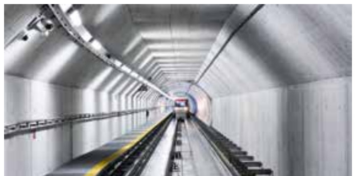
Während in einem Tunnel der Betrieb der Skymetro weiterläuft, arbeiten bis zu 20 der 30 Gewerke gleichzeitig im anderen Tunnel.
