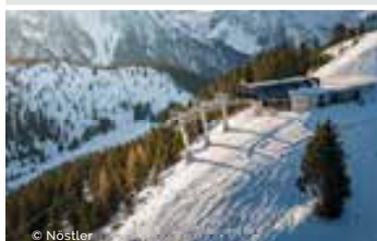
10EUB Loischkopfbahn Bürserberg, Baujahr 2025
