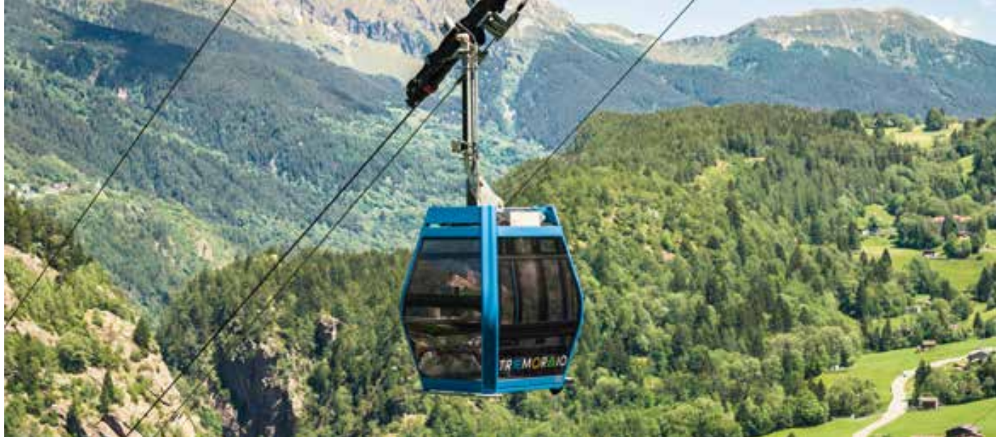
Steile Hänge, tiefe Schluchten und weite Seilfelder: RopeTwin ist die neue Generation der Pendelbahn für anspruchsvolles Gelände. © Bartholet
