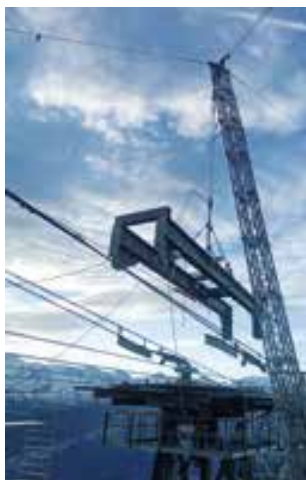
Mit der Montage-Nadel wurden schweren Teile transportiert.
