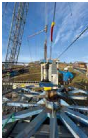
Die Umlenkscheibe wird demontiert.
