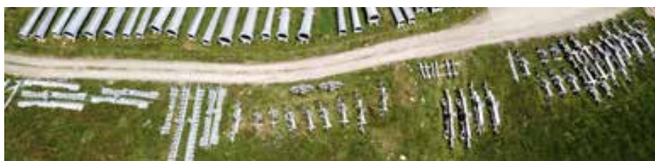
Tonnenweise Material wurde mit Lastwagen zur „doppelten“ Talstation geführt. © Inauen-Schätti
