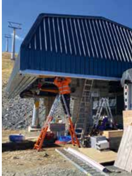
Bauarbeiten an der Talstation im Meierhoftäli.
