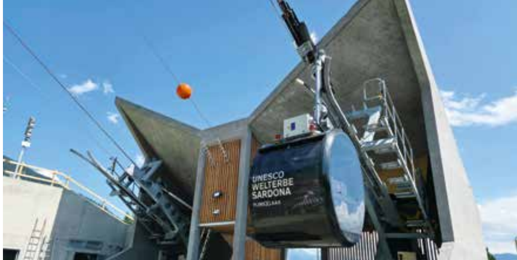
Milchseilbahn Fidaz–Flimserstein: Die RopeTwin -Anlage wurde in erster Linie für die Alpbetriebe gebaut und bringt täglich bis zu 650 Liter Milch ins Tal. © Bartholet
