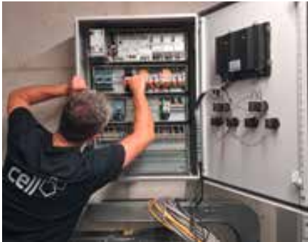
Vernetzte Fernwerkstationen sorgen für Messdatenerfassung, Datenweiterleitung und Steuerung. © cell GmbH
