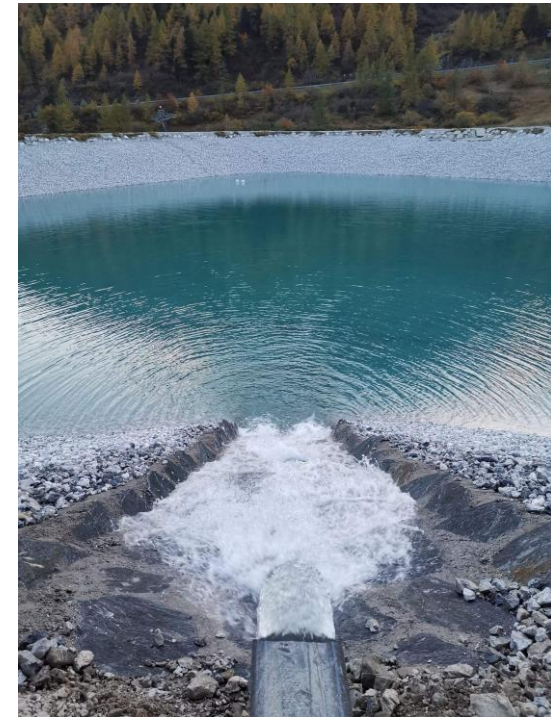
Zulauf Schneispeicher: Beschneigung braucht große Wassermengen
