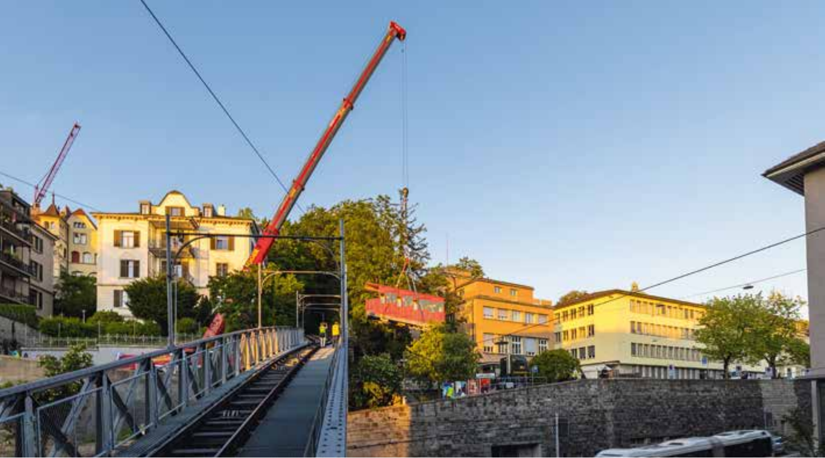
Die Standseilbahn aus dem Jahr 1889 erhielt eine Totalmodernisierung. Diese umfasste einen neuen Antrieb und eine Steuerung. Foto: GARAVENTA/Christian Betschart
