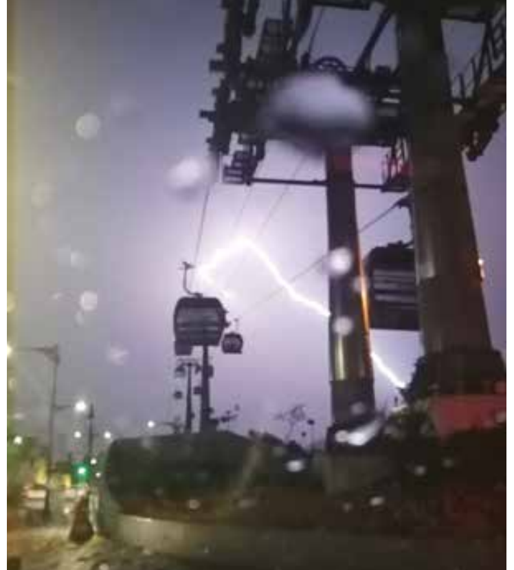
Die urbanen Seilbahnen in Lateinamerika werden häufig von Blitzen getroffen. Dank TRUscan kann der Betreiber seine Anlage trotzdem mit gutem Gewissen in Betrieb nehmen. Bilder: FATZER
