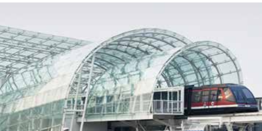
Dank der großen und freizügigen Kuppel aus Stahl und Glas wirkt das Gebäude des People Movers in Venedig von innen und außen großzügig und offen. Foto: OskarDaRiz
