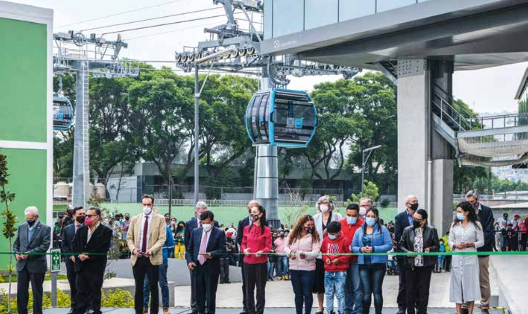
TÜV SÜD ist weltweit im Einsatz, wie hier bei der Prüfung der Stadtseilbahn in Mexiko-Stadt. Fotos: DOPPELMAYR GRUPPE
