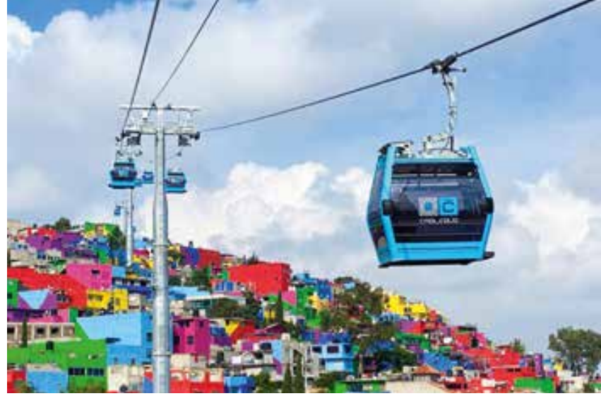
LEITNER wird den Cablebús 2 gemeinsam mit dem mexikanischen Partner Alfa Proveedores Contratistas ein Jahr lang betreiben. Für den Betrieb der Bahn werden 300 Personen im Einsatz sein.
