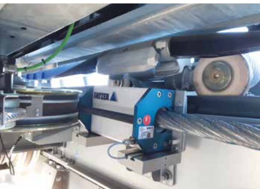
Mit dem TRUscan können Förderseile bis zu einem Durchmesser von 64 Millimetern berührungslos auf Drahtbrüche untersucht werden.
