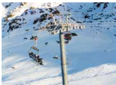
Die Bahn verläuft über eine Strecke von 735 Metern und wird von acht Stützen getragen.
