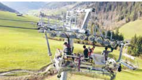
Die Plattform vereinfacht die Wartung, spart Kosten und Zeit und trägt zur Sicherheit und Zuverlässigkeit der Seilbahnen bei. © COLOMBO
