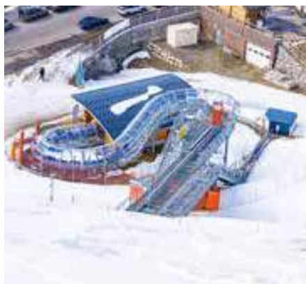
Die Stationsgebäude inklusive Ausstiegsband, überdachter Staustrecke und Bergförderer.
