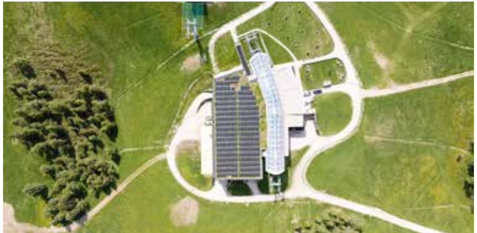
PV-Anlagen errichtet der „Kronplatz“ in erster Linie für sich und nicht für die Gäste. © Kronplatz
