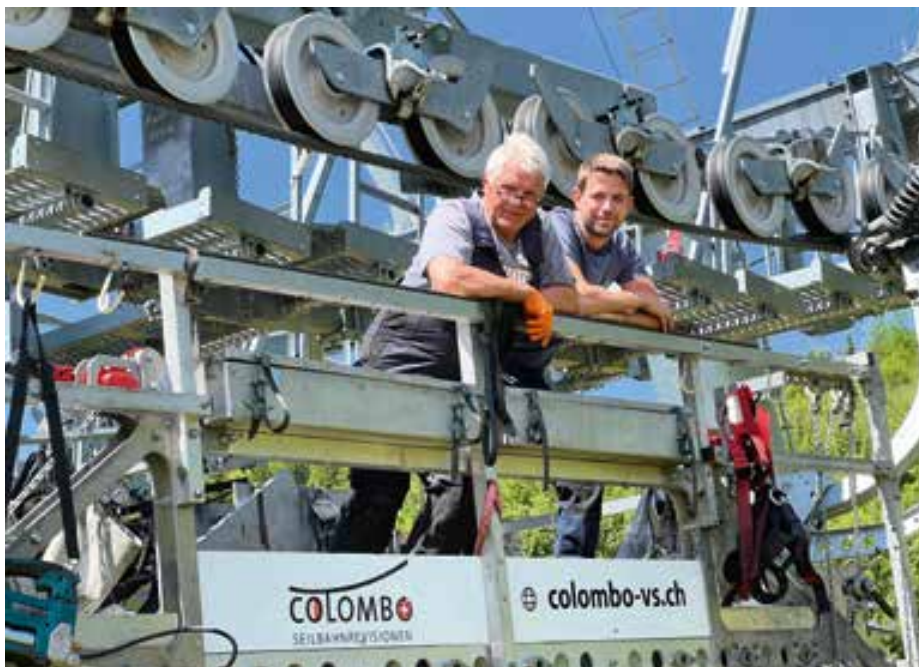
Stephan Colombo (links) und Philipp Rodeghiero benötigten bei der Schönbergkopfbahn im Lachtal für die Revision von 22 Rollenbatterien nur 20 Tage – dank der Wartungsplattform. © Lachtal-Lifte
